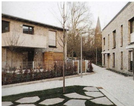
Hannover-Limmer St. Nikolai-Viertel KSW - Kellner-Schlaich-Wunderling
